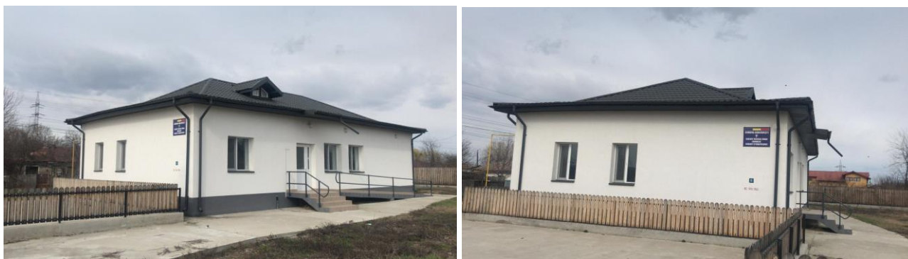
Dispensar medical, cabinet stomatologic și farmacie corp clădire nou - sat Tătărani
